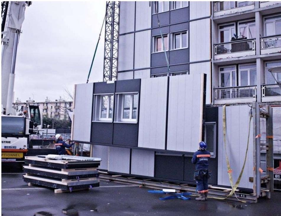
*Comme l'a expliqué Marc Benard de l'agence Equateur, la préfabrication à base de Panobloc a permis d'atteindre une haute performance thermique et acoustique par une intervention propre et rapide en respectant l'expression architecturale initiale. ©Equateur*
