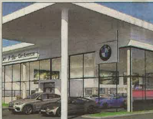
Les deux concessions disposeront de 6 500 m 2 de bâtiment dont un atelier partagé. Photo ER/Ghislain UTARD
