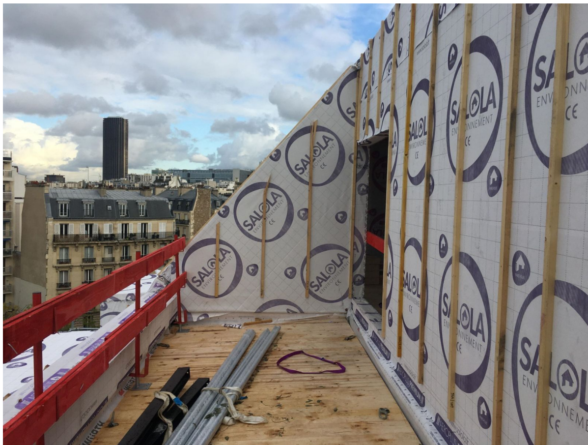
Les balcons-terrace en CLT repose sur les éléments de la façade à ossature bois. ©Olivier Terrones/AGT
