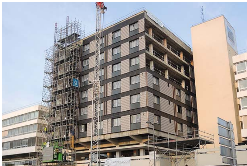
Façade de l'immeuble Sogé 2000 à Cergy en cours de réhabilitation grâce à des panneaux bois Panobloc de Techniwood
