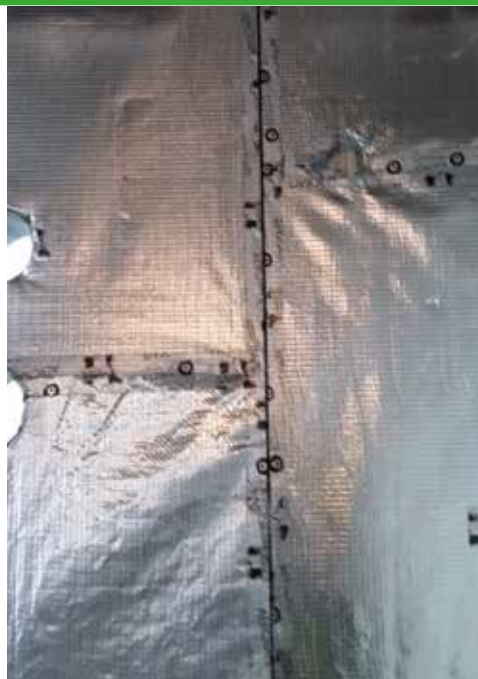
Les jonctions entre panneaux sont étanchéifiées avec des adhésifs.
