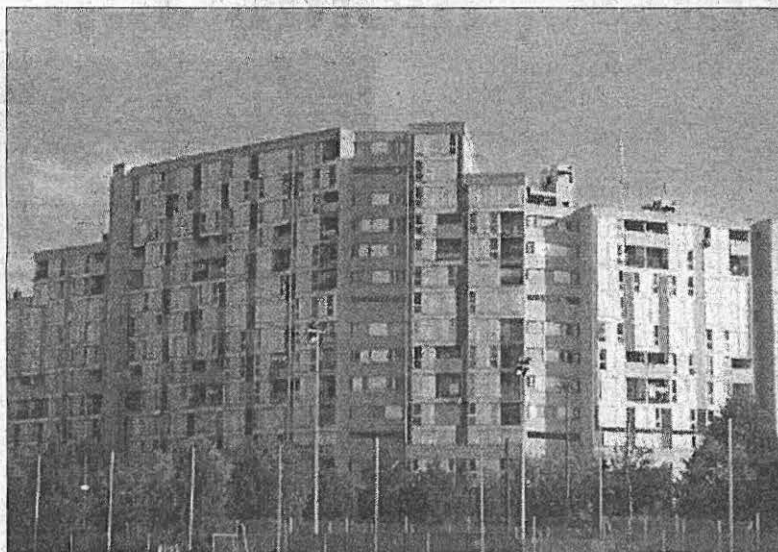
Parmi les chantiers en cours, la rénovation d'un immeuble de 15 étages à Grenoble (DR).
