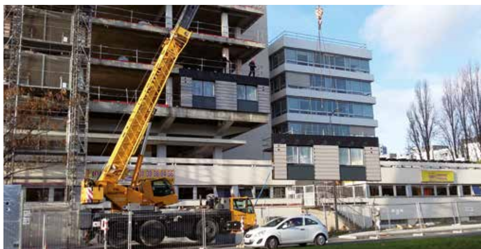
Le chantier s'est déroulé en seulement 4 semaines, dans une zone très passante à l'accès compliqué.
