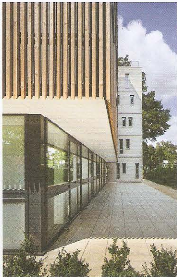
▲ Les césures verticales renforcent le contraste entre le bardage bois et le revêtement minéral.
