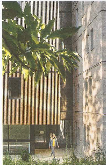
▲ Les césures verticales renforcent le contraste entre le bardage bois et le revêtement minéral.
