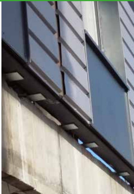
Vue des ferrures au premier niveau.
