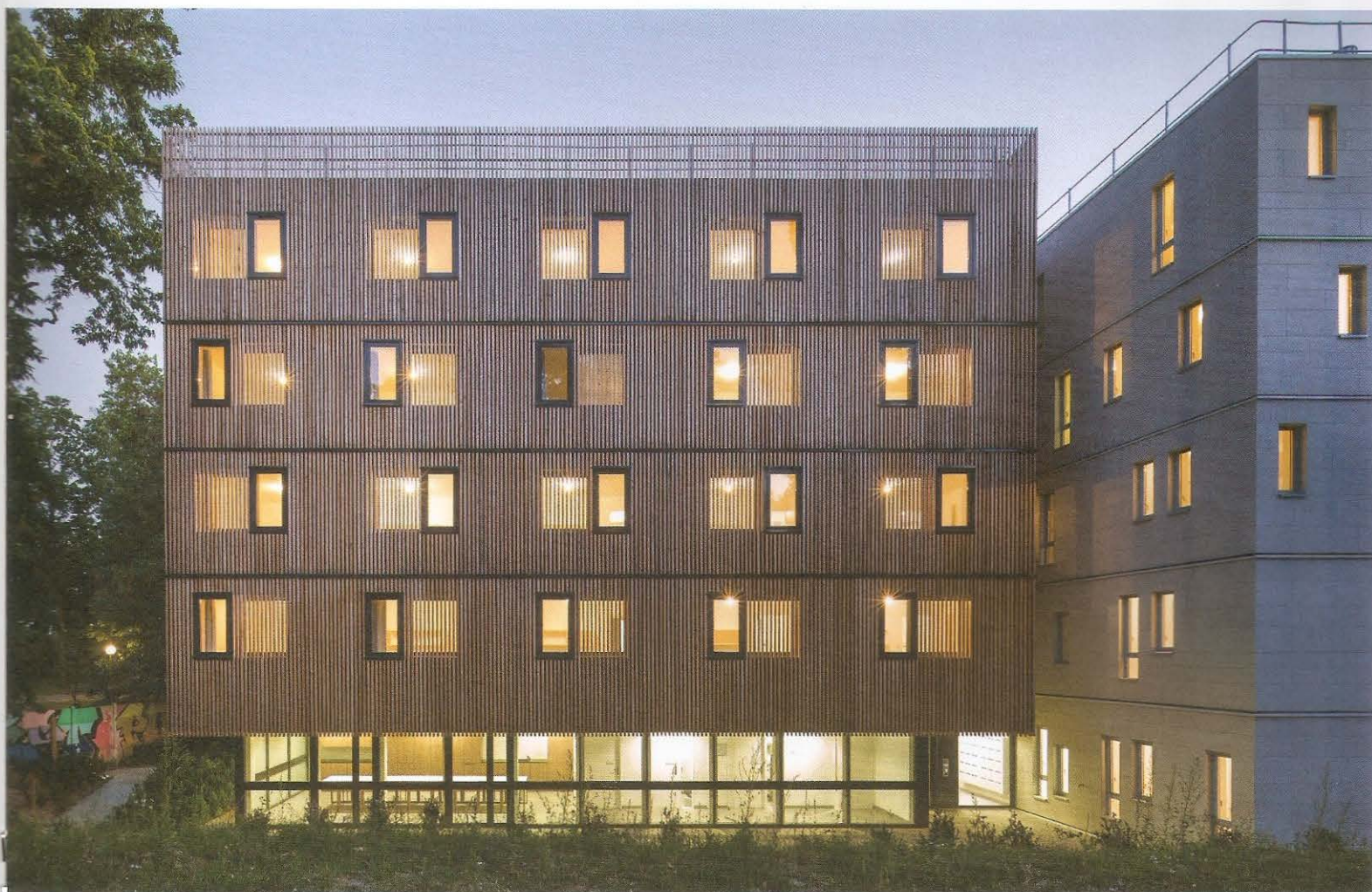
▲ L'éclairage nocturne de la façade arrière souligne le caractère diaphane du bardage à claire-voie et le jeu des ouvertures.
