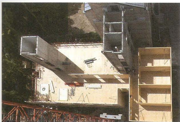
▲ Les cages en béton attendent le montage des panneaux de bois des planchers.
