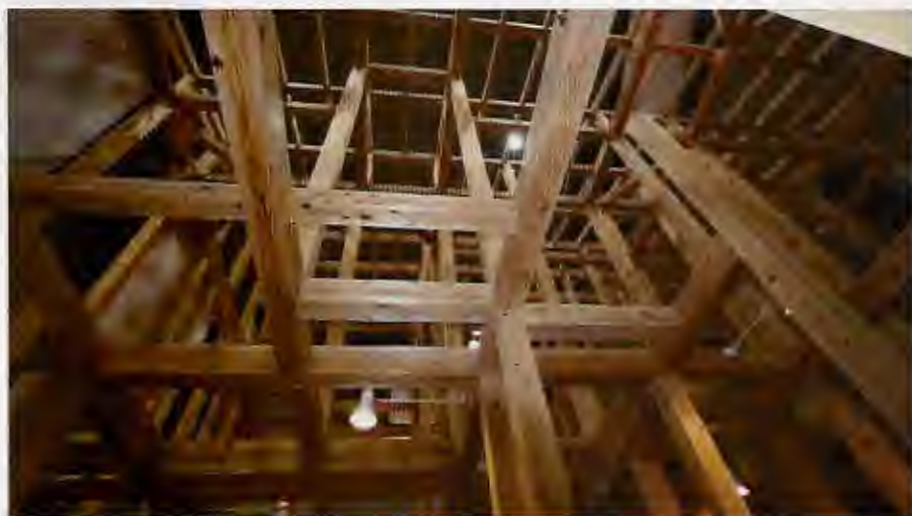
Op de bouwplaats worden alle onderdelen genummerd aangeleverd. De stalen connectoren worden met een eenvoudige hamerslag in het vooraf ingefreesde hout gedreven, zodat palen en balken millimeten nauwkeurig en in een maat van tijd volgens plan gemonteerd worden.
