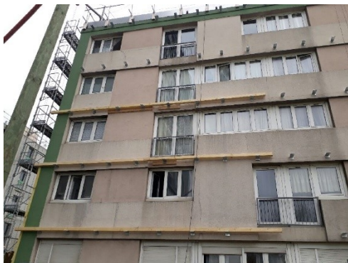
Phase de pose des équerrres et lisses.
